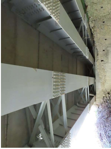
VISTA INFERIOR DE LA ESTRUCTURA
