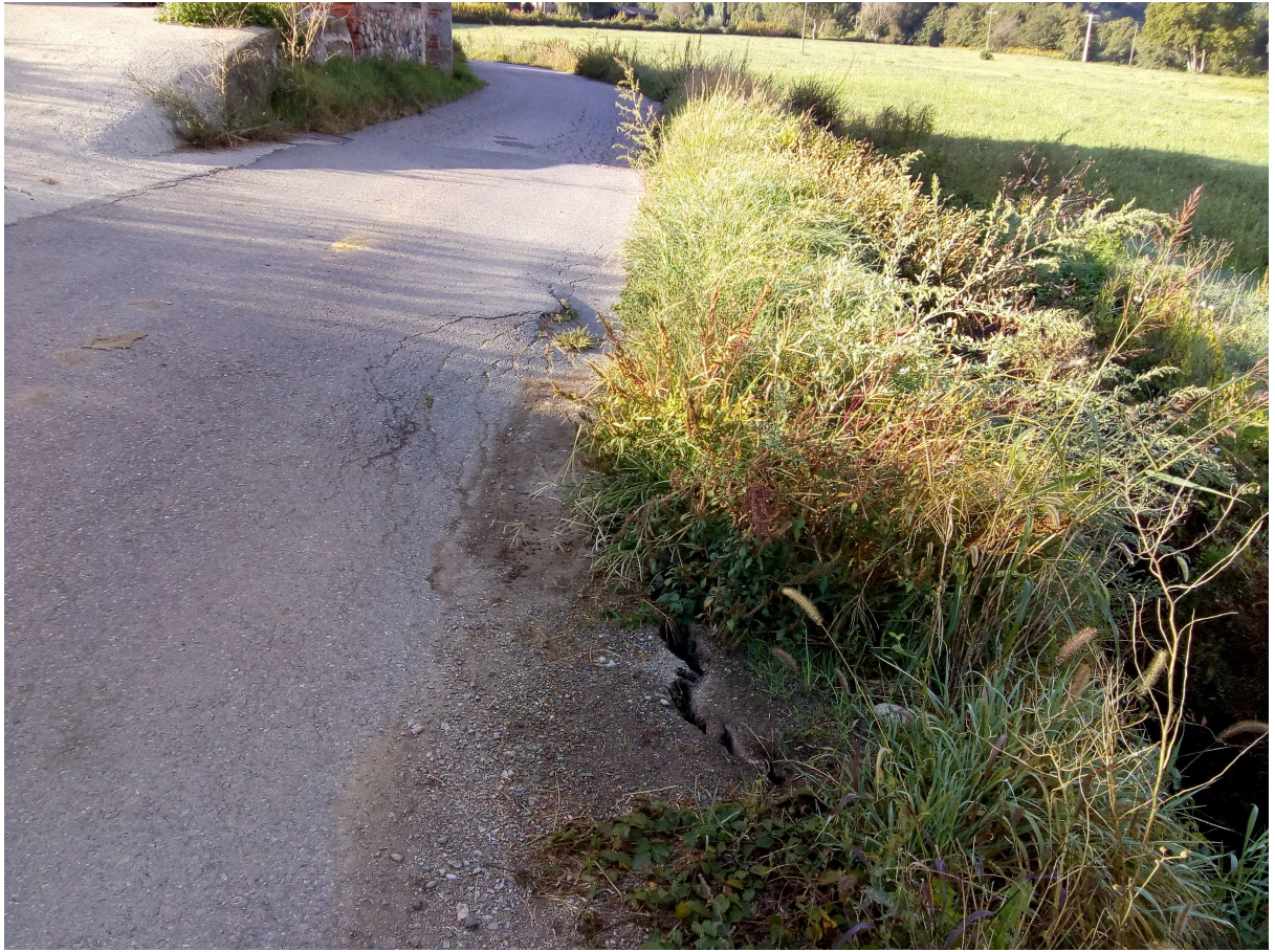
Detall del paviment trencat
