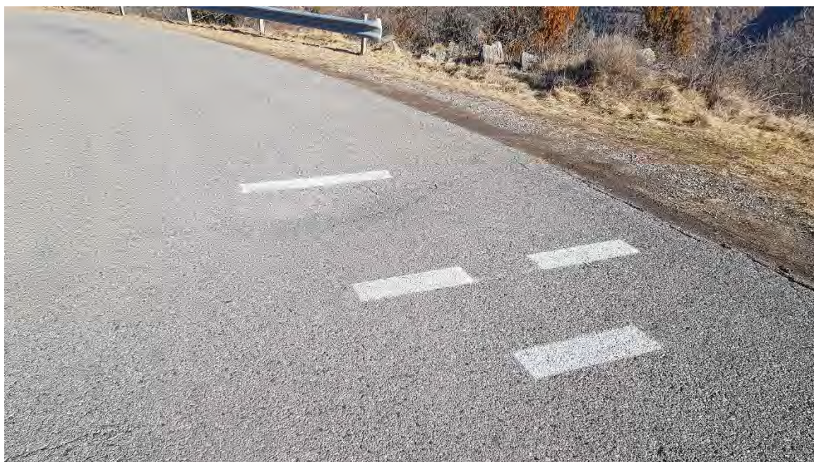
Estat actual del camí
