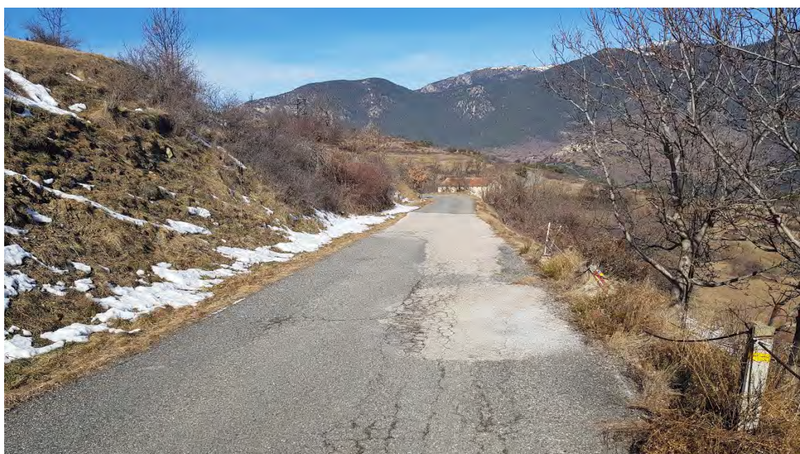
Estat actual del camí
