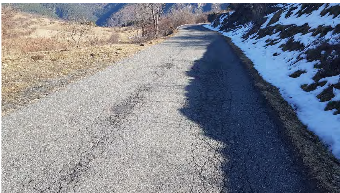
Estat actual del camí
