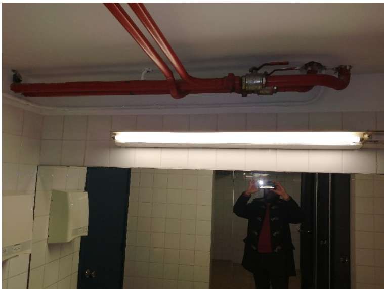
13. sostre lavabos soterrani. Instal·lació calefacció
