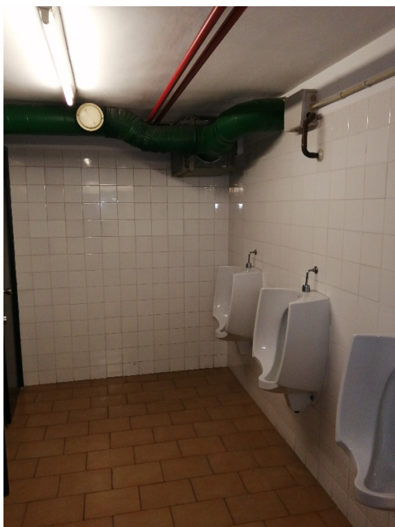
14. sostre lavabo soterrani. Instal·lació ventilació
