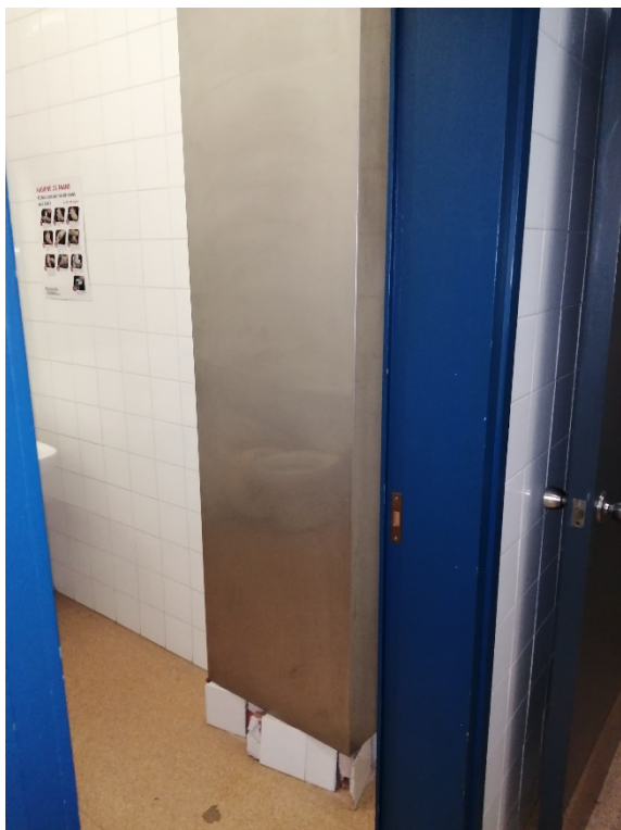
07. calaix instal·lacions a desplaçar en lavabo PMR
