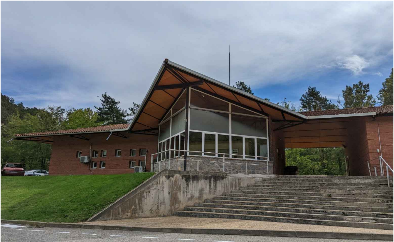
VISTA DE LA FAÇANA
