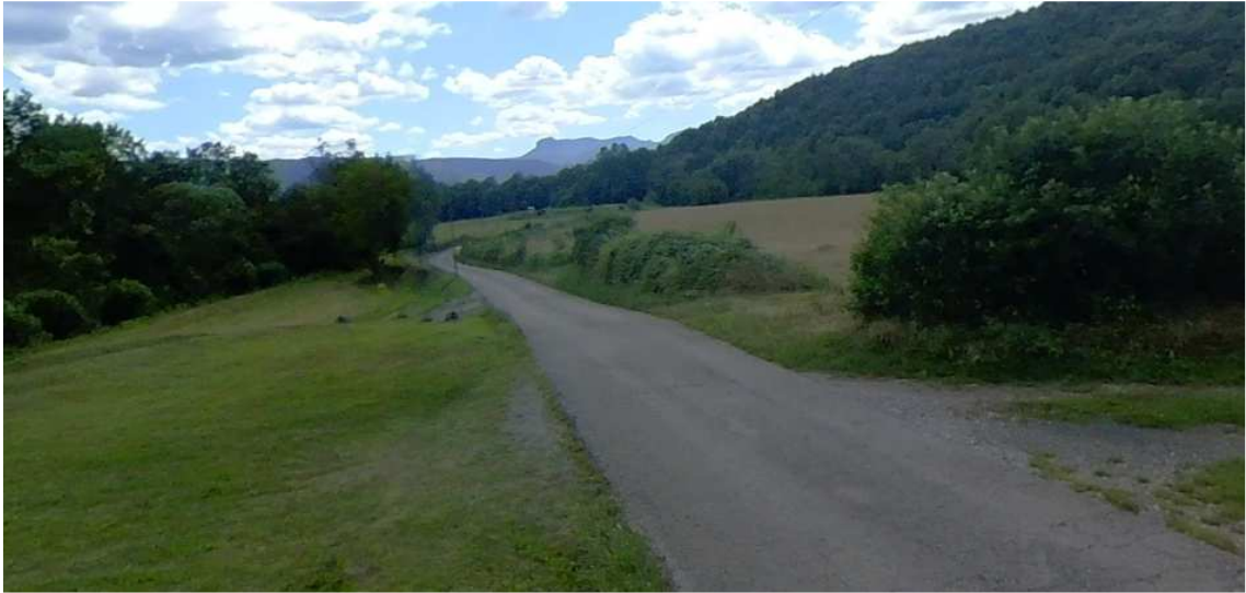
Foto 1.- Vista general del camí- pk 0+120
