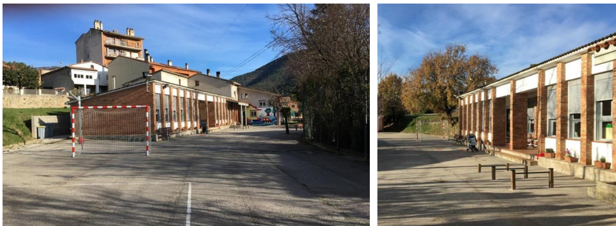
(Imatges estat actual pati escola)
