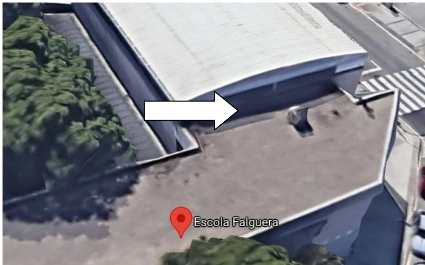
Figura 9: Detall Ubicació de l'Inversor
