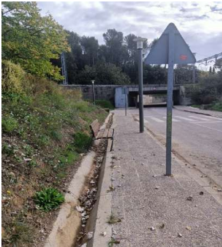
CUNETA PEU DE TALÚS CAMÍ DEL CEMENTIRI
