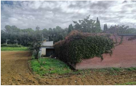
CUNETA LATERAL DE TERRES
