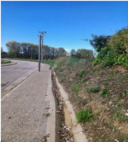
CUNETA PEU DE TALÚS - CAMÍ DEL CEMENTIRI
