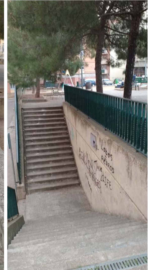
F8. Imatge de l'escala de la plaça de l'Emigrant com a connexió amb el Passatge Algesires inferior. Aquesta escala no serà objecte de cap modificació ja que la nova pavimentació de la plataforma amb sauló estabilitzat mantindrà les cotes i rasants actuals.
