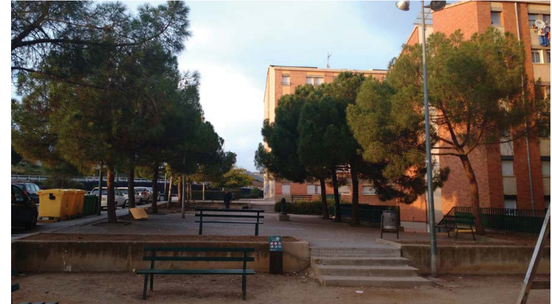
F3. Detall de l'estat actual de l'escala que separa les dues plataformes inferiors. S'observa com el graonat és desigual, no disposa de barana i el paviment no és homogeni. Es proposa la creació de la nova escala (amb barana) de banda a banda de la plataforma, així com la substitució dels bancs per nous models de banc. També es proposa crear nous accessos a la plataforma intermitja a través de una rampa més àmplia que l'actual.
