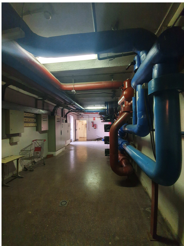
Foto 08. Sala de bombes
