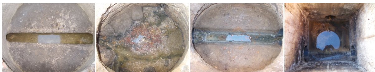
Estat pous xarxa clavegueram existent
