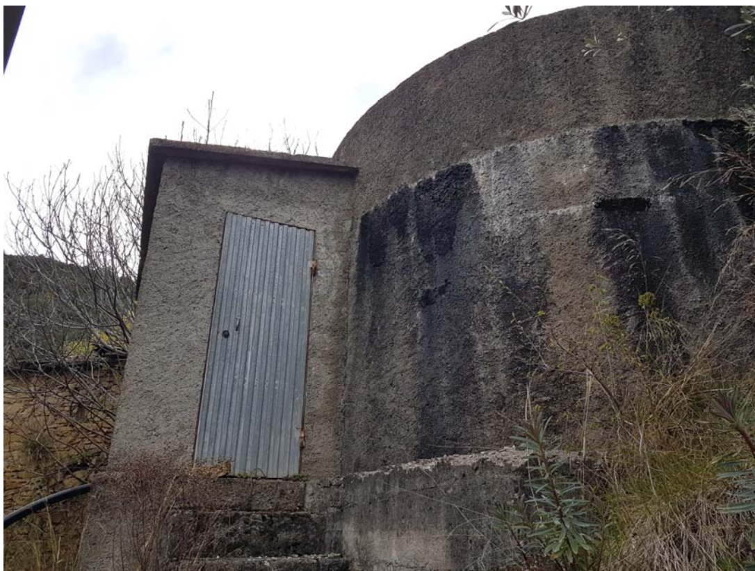
Foto 26: Caseta del dipòsit antic de 40 m 3
