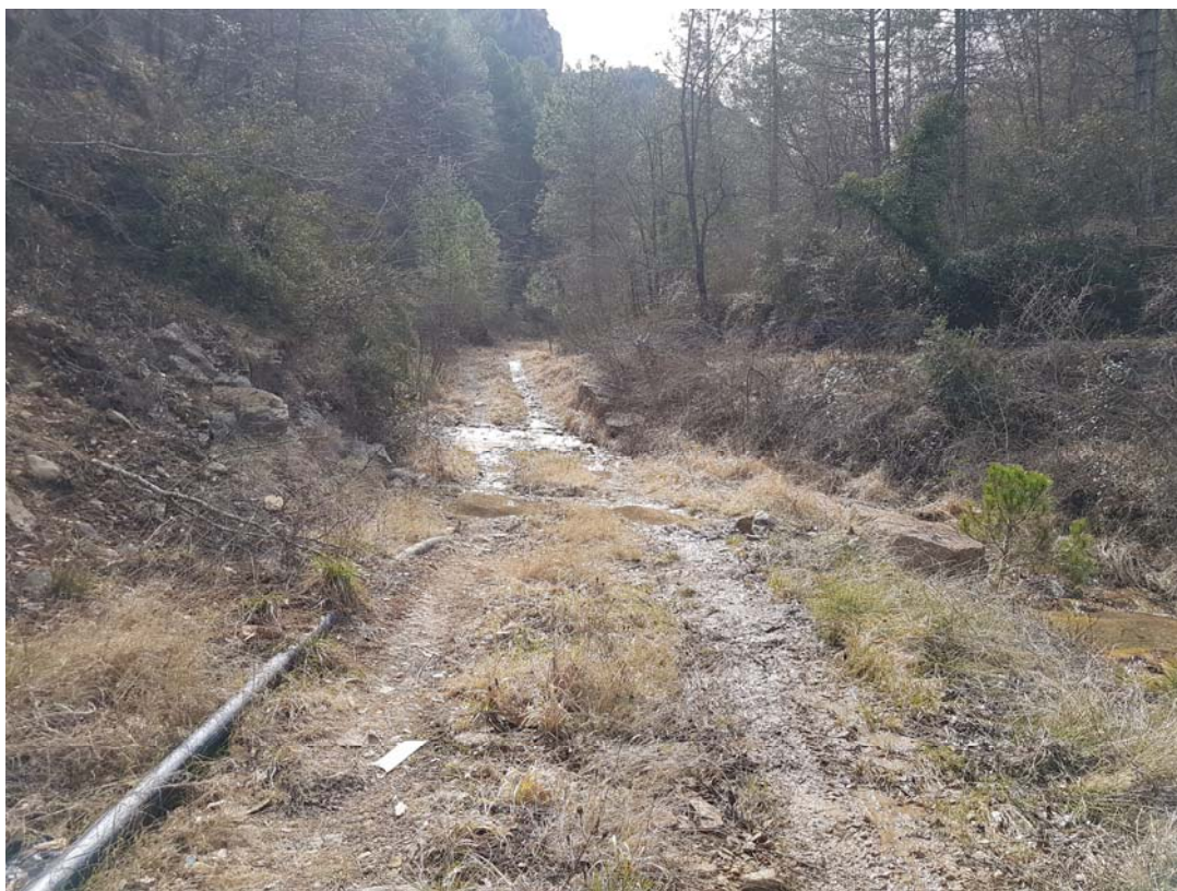
Foto 8: Creuament 1 sota barranc. P.Q. 0+036 (vista aigües amunt)
