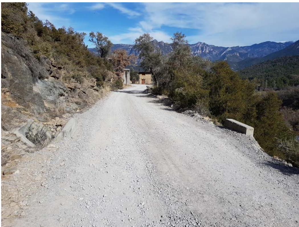
Foto 22: Camí i obra de drenatge existent P.Q. 1+879 (vista aigües avall)
