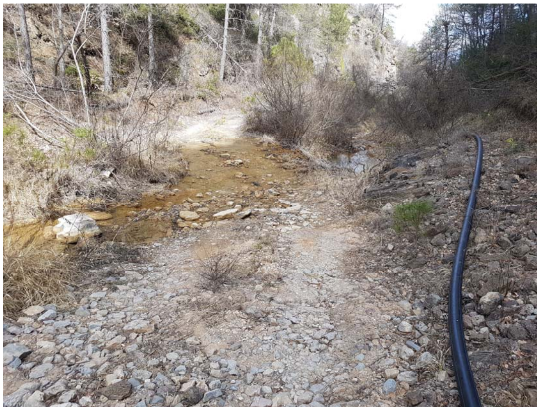
Foto 10: Creuament 2 sota barranc. P.Q. 0+187 (vista aigües avall)
