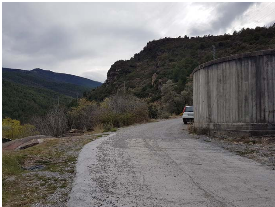
Foto 29: Emplaçament dels dos dipòsits existents. Dreta dipòsit nou i esquerra dipòsit més antic.
