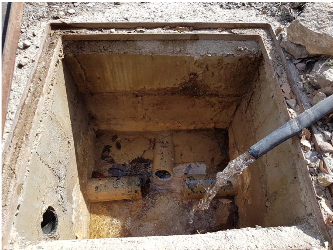
Foto 19: Arqueta existent escomesa Masia de Cal Music, P.Q. 1+327 (vista aigües avall)
