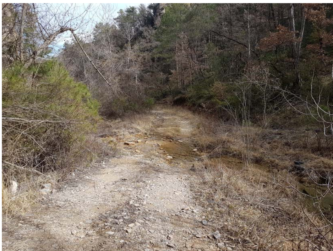
Foto 12: Creuament 3 sota barranc. P.Q. 0+263 (vista aigües avall)
