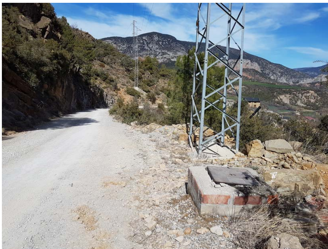
Foto 21: Camí i arqueta existent de trencament de càrrega P.Q. 1+550 (vista aigües avall)
