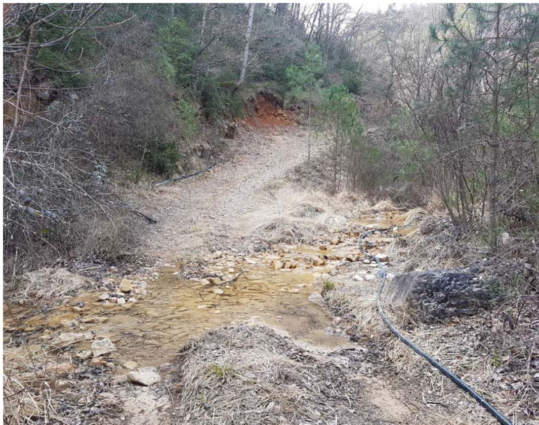
Foto 15: Creuament 4 sota barranc. P.Q. 0+453 (vista aigües amunt)
