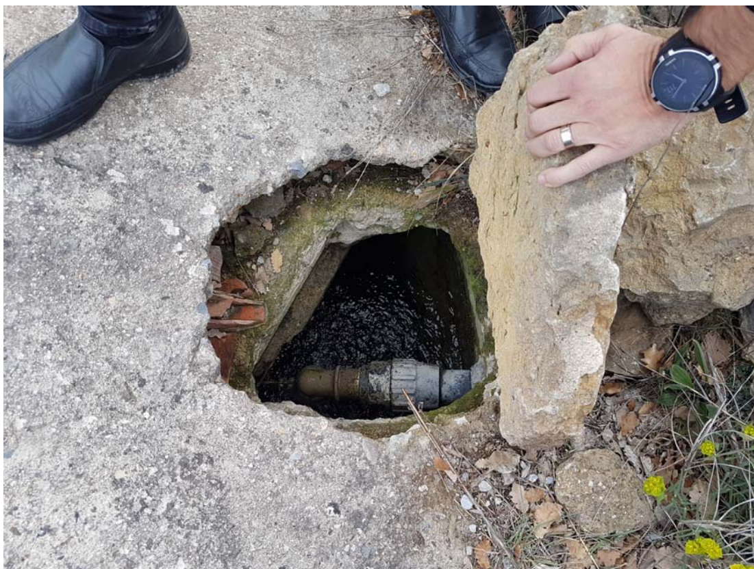
Foto 25: Resgistre canonada d'entrada d'aigua en la coberta del dipòsit antic de 40 m 3
