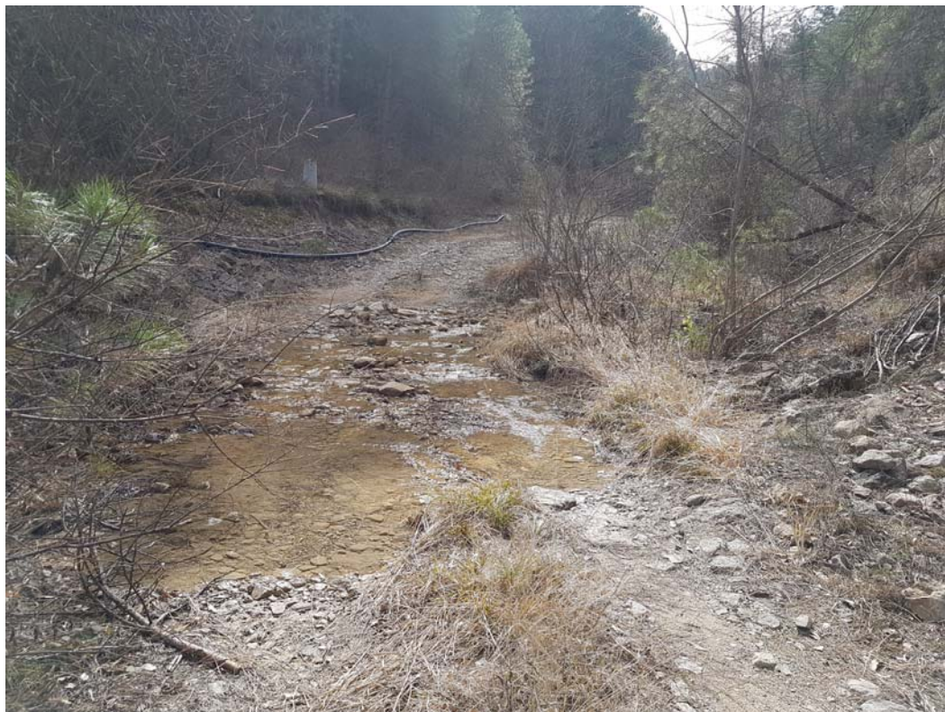
Foto 11: Creuament 2 sota barranc. P.Q. 0+187 (vista aigües amunt)
