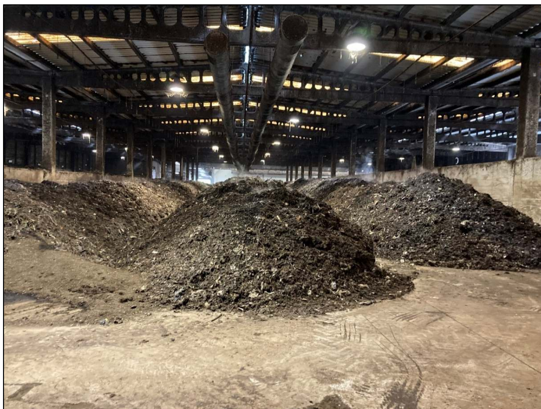
Foto-03. e30.21.spr.sistema de reg-220503. 1 Sitja x 3 Piles. Estructura.
