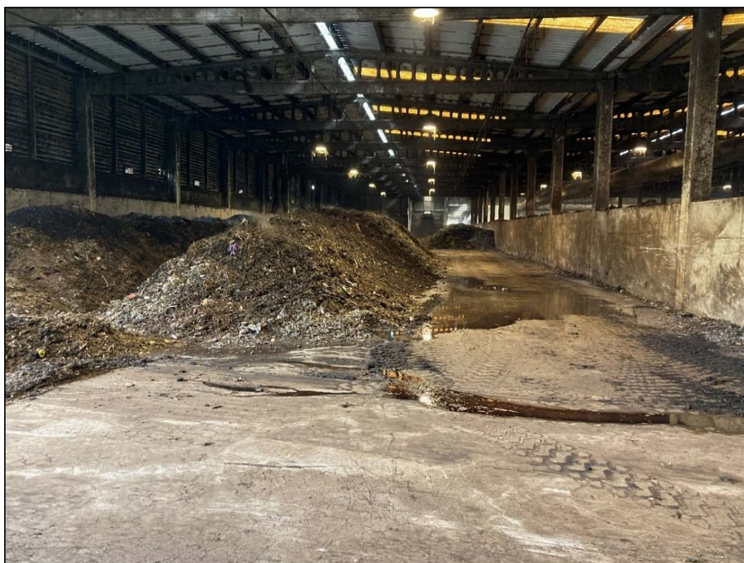
Foto-02. e30.21.spr.sistema de reg-220503. 1 Sitja x 3 Piles. Estructura.
