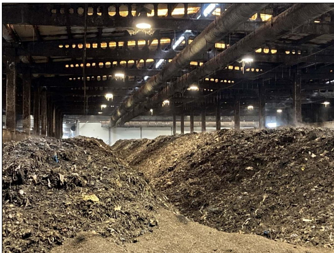
Foto-04. e30.21.spr.sistema de reg-220503. 1 Sitja x 3 Piles. Estructura.
