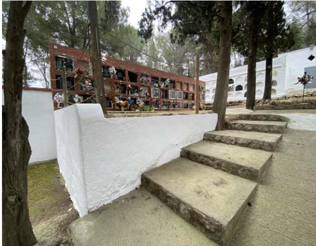
Escalles a rehabilitar
