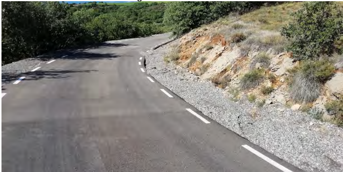
Estat actual de la cuneta a formigonar
