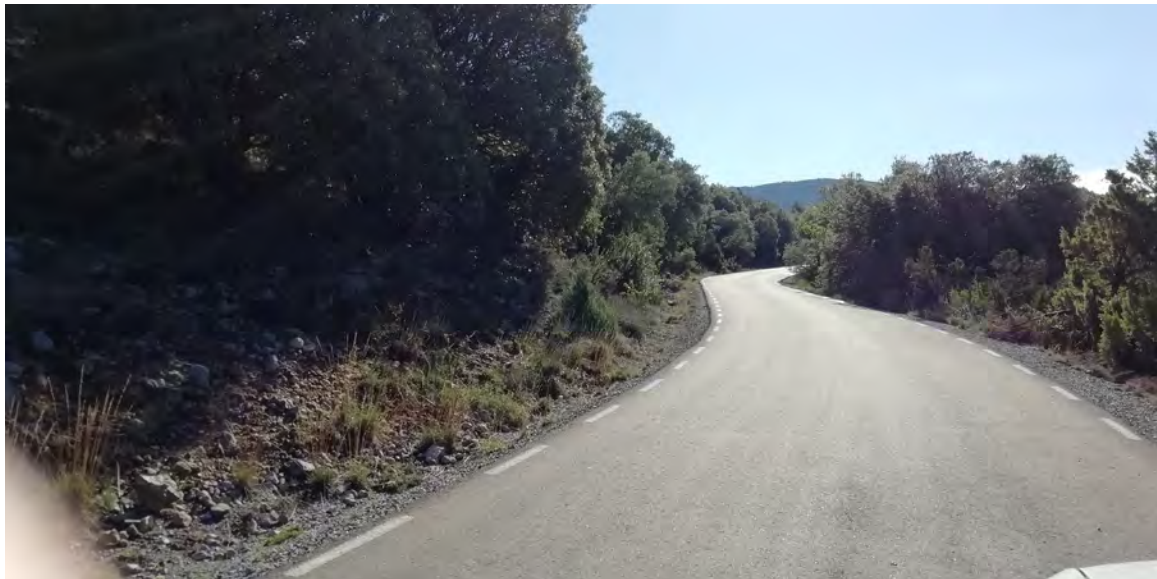
Estat actual de la cuneta a formigonar
