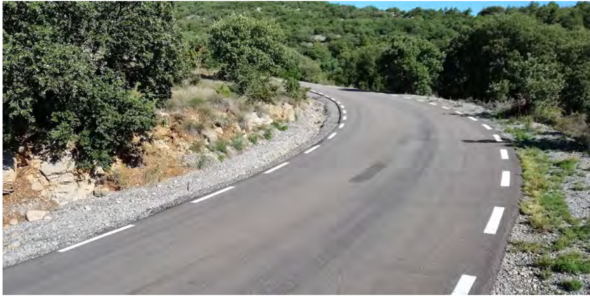
Estat actual de la cuneta a formigonar
