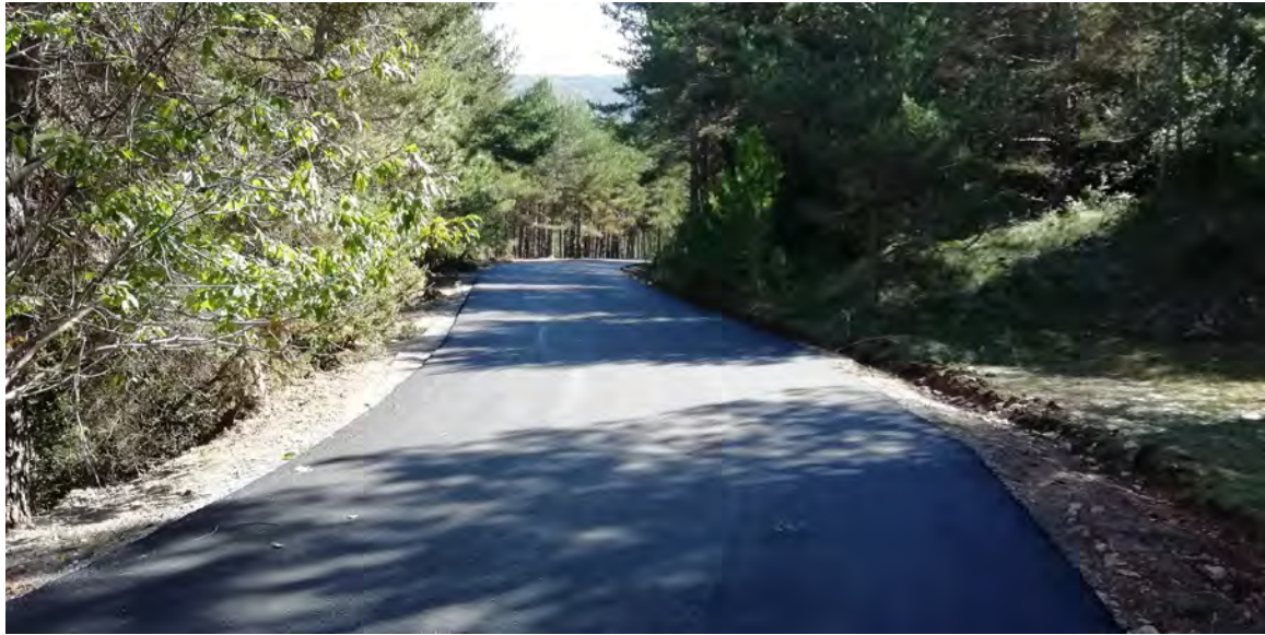
Estat actual de la cuneta a formigonar
