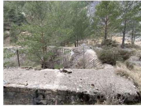
Neteja i barana en la zona de la tolva
