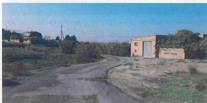
Xarxa elèctrica existent on connectar la nova bàscula.
