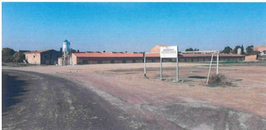
Zona a instal·lar la nova bàscula.
