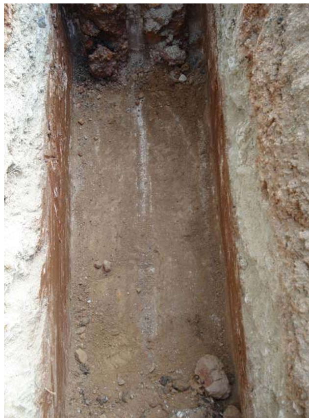
Fotografia 5: Solera de formigó corresponent, probablement, al sostre d'un calaix-col·lector detectat a la cala C-8 a 1,0 m de fondària.
