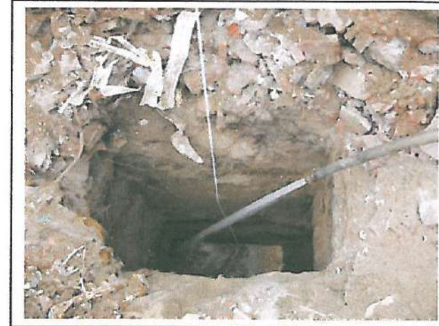
Foto 16: Ompliment d'aigua a la Cata 2 a 4.0 m de profunditat.
