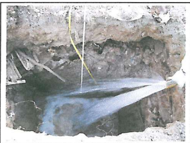
Foto 21: Ompliment Cata 3 entre 1.30-2.30 m de profunditat.
