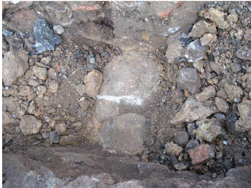
Fotografia 2: Tub de formigó – col·lector a 0,55 m de fondària.
