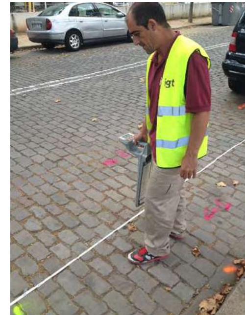
Ejecución de las medidas con el sistema Radiodetection.
