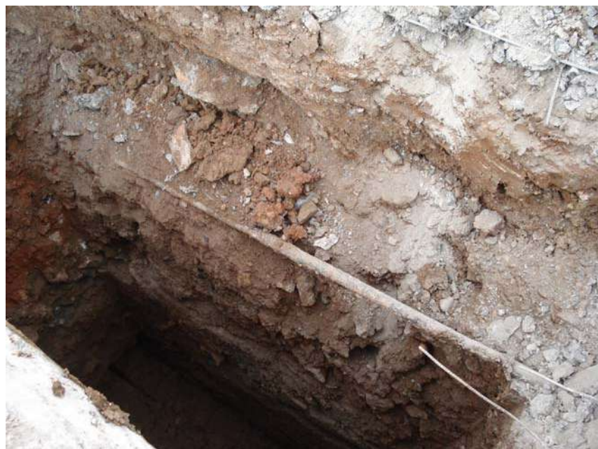
Fotografia 6: Tub metàl·lic d'uns 3 – 4 cm de diàmetre detectat a 1,0 m de fondària a la cala C-20.
