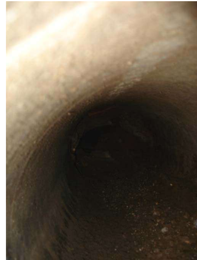
Fotografies 3 i 4: Tub col·lector e interior del mateix detectat a la cala C-7 a 1,1 m de fondària.
