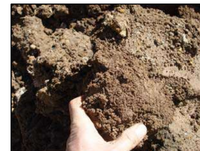
DETALL ARGILES SORRENQUES
