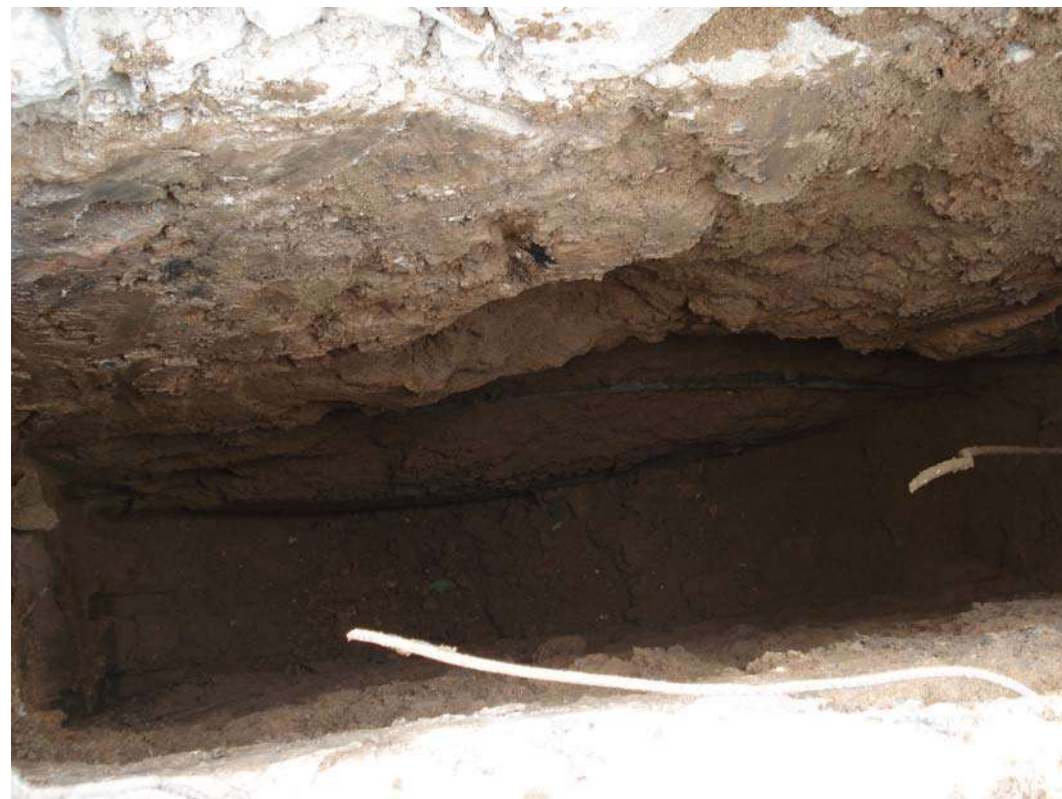
Fotografia 9: Tub de plàstic-PVC negre detectat a la cala CV-11 a 2,0 m de fondària
