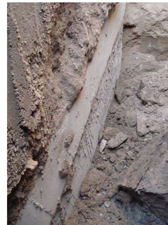
Fotografia 8: paret de calaix-col·lector detectat a partir de 1,5 m de fondària a la rasa C-25.
