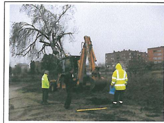
Foto 1: Cata 1 a la Antiga Fàbrica Miniwat.Pg.Zona Franca (Barcelona).
