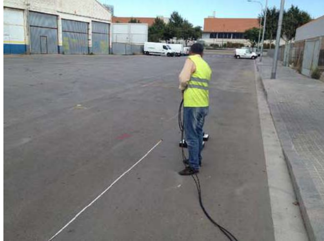
Ejecución de medidas con el GeoRadar 225MHz
