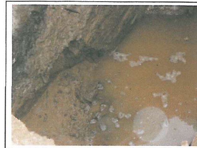
Foto 13: Detall del punt per on marxa l'aigua a la Cata 2.
