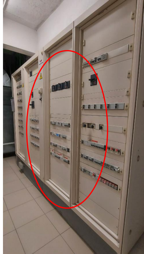
Imatge 6 i 7) Comptador TMF10 i Quadre General de Baixa Tensió on es connecta la producció FV, amb espai reservat per instal·lació magneto tèrmic.
