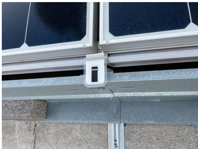
Imatge 17) Exemple de sonda de irradiància solar.
