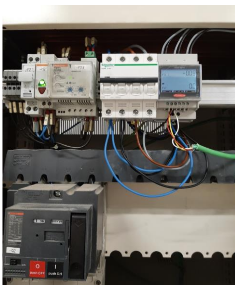
Imatge 18) Exemple smartmeter tipus Fronius.
