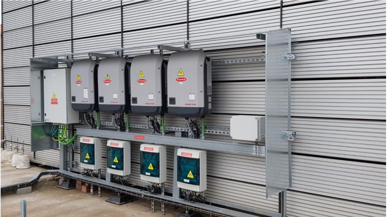
Imatge 20) Exemple sensor Box Tipus Fronius i teulat d'acer inoxidable per protegir els inversors.
