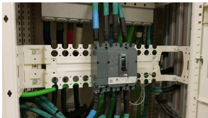
Imatge 19) Exemple magneto tèrmic producció FV.
