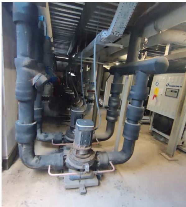
Fig. 6 Bombes que donen servei d'aigua condensació per a les centrals de fred industrial
