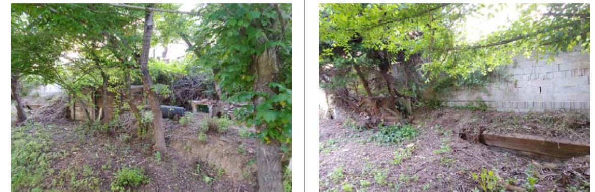
Aspecte general talús nord
