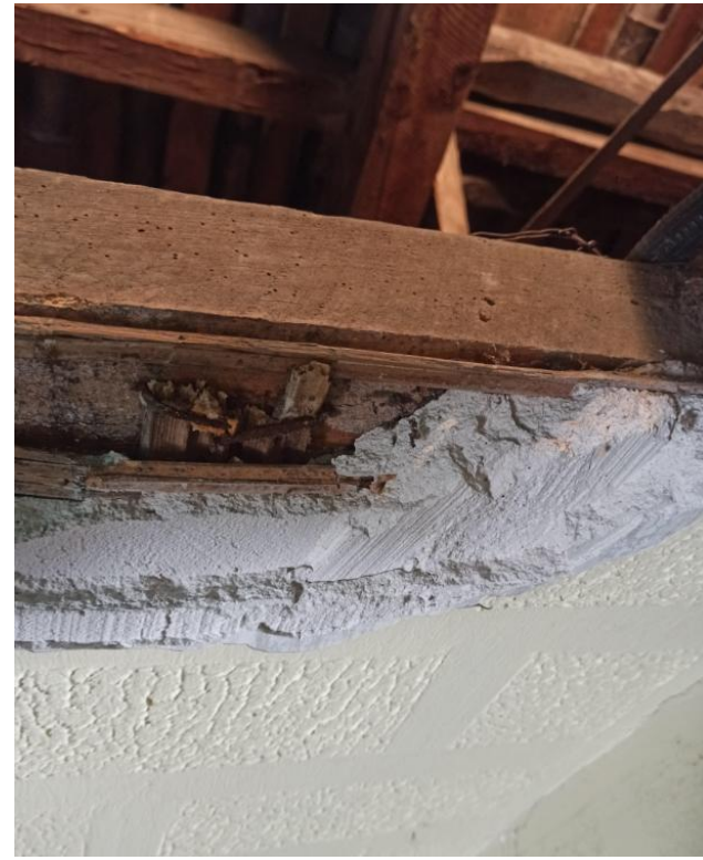
Secció del cel-ras i llistó de fusta de suport JS (2021)
