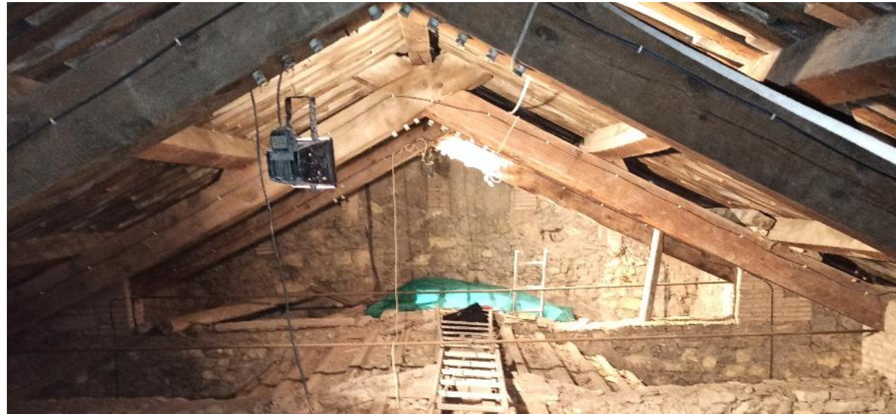
Encavallades sense tirant de fusta
