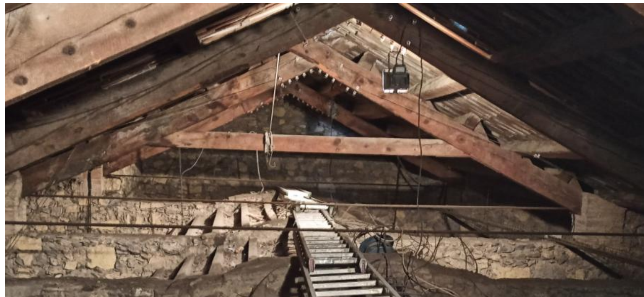
Encavallades amb tirant de fusta
