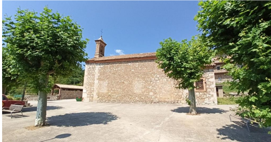
Façana est i detall finestra JS (2021)
