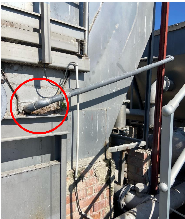
Punt d'aport d'aigua al canal de recollida de desbast amb la xarxa d'aigua de servei de l'EDAR.
