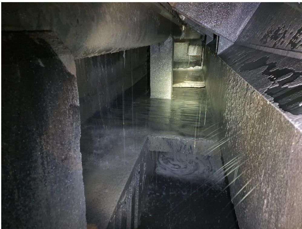
Fotografia núm. 2: Arqueta-cubeta inferior de recollida de l'aigua filtrada als tamisos on caldrà fer els murs d'obra provisionals per contenir l'aigua d'un costat i de l'altre.
