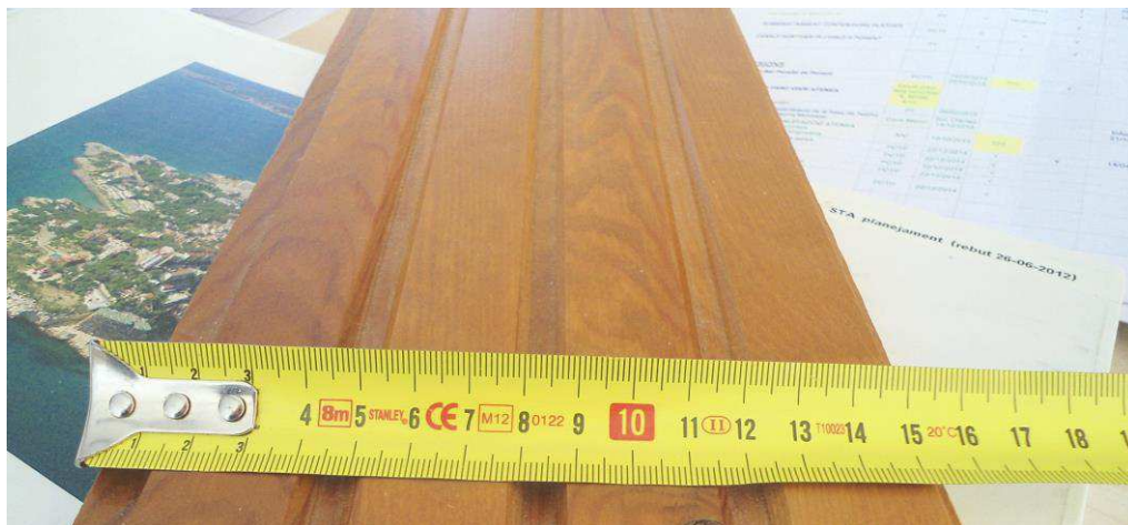
Aspecte estètic de l'encadellat exterior de fustes de les guinguetes de platja
