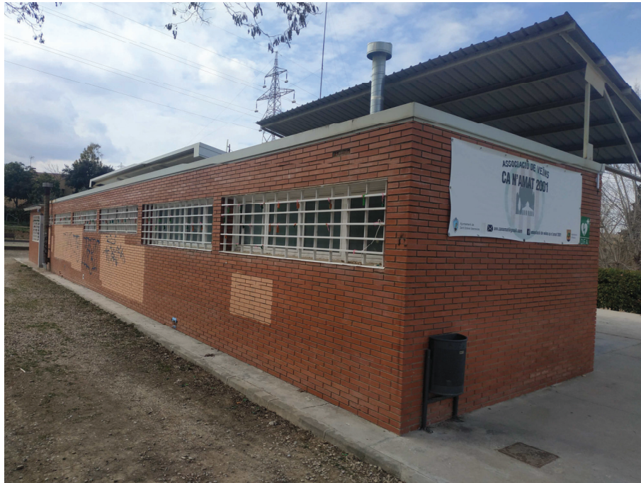
Fig. 2 Vista façana sud
