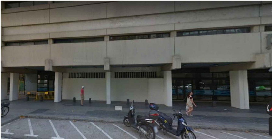
Fot. 6. Tancament de vestidors que impedeixen veure l'evador per la façana nord-est
