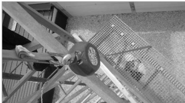
*Figura 3. Ejemplo posicionamiento incorrecto dispositivo retráctil*
