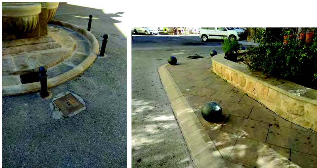
Vista de les proteccions instal·lades per la font i altres elements de la plaça
