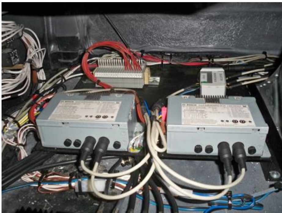
Imagen 2. Instalación en hueco escalera trasera de amplificadores y bornero de megafonía
