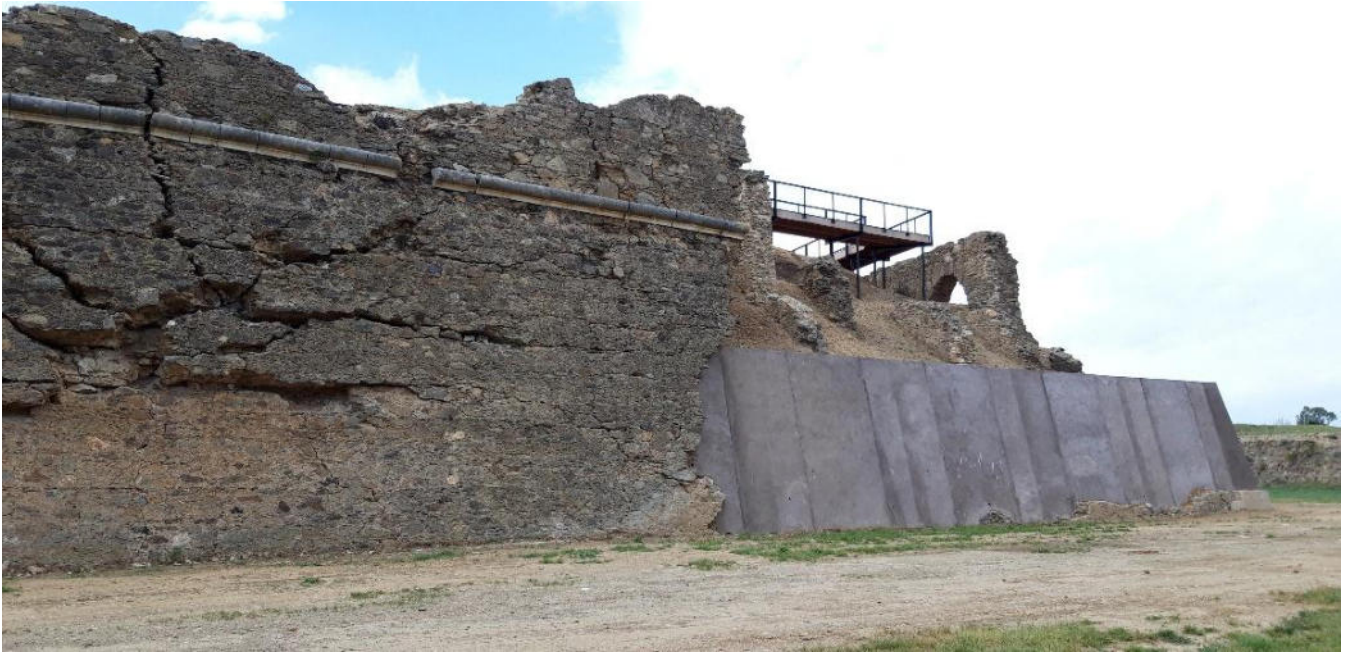
Vista de la fachada noreste del baluarte de Sant Andreu con la muralla de piedra y la de hormigón
