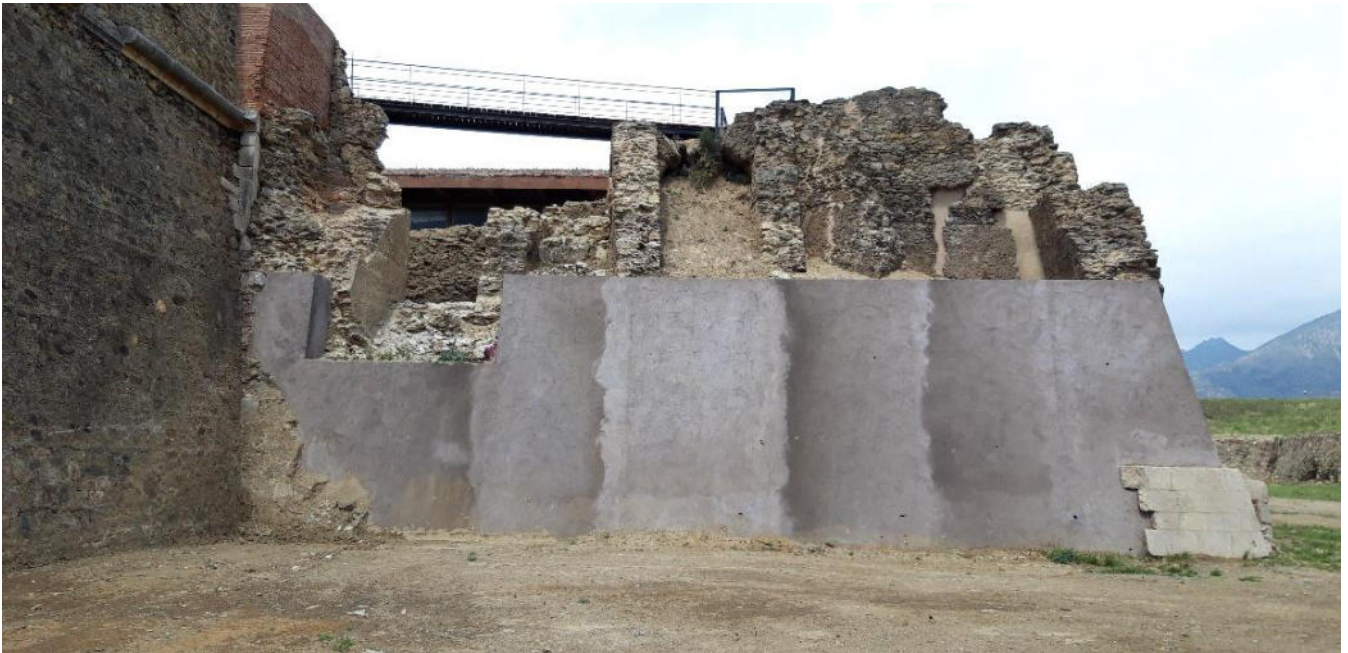
Vista del estado actual de la fachada este del baluarte de Sant Andreu con el muro de hormigón
