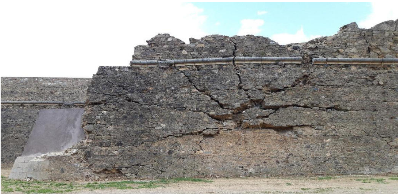
Vista de la fachada noreste del baluarte de Sant Andreu con parte de muralla de piedra agrietada.
