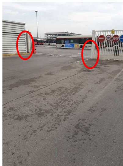
8 Ubicación Lectores de salida
