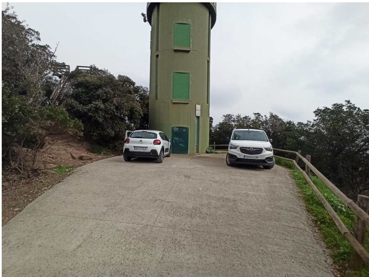
Figura 6. Vista del radar de l'espai davant de l'edifici.
