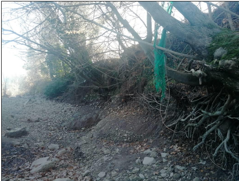
Imatges de la zona de llera i marge on s'actuarà i es construirà el mur d'escullera
