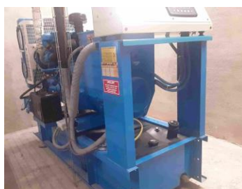
Grup electrogen (sala comptadors de baixa)
