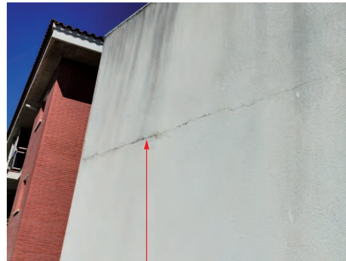
15.02. OBRIR, POSAR MALLA I PINTAR TOTA LA FAÇANA
