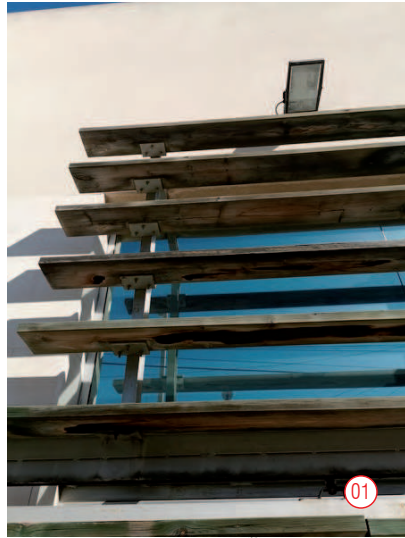
01.01. ARRENCADA DE GELOSIA DE FUSTA 01.02. DESMUNTATGE DE REIXA, ANCORATGES I PORTA
