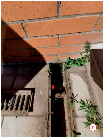
08.01. ARRENCADA DE CANAL DE DESGUAS
