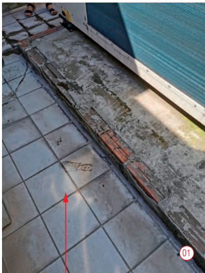
26.01. GOTERA EN PLANTA PRIMERA EN CEL FALS (FOCUS)
