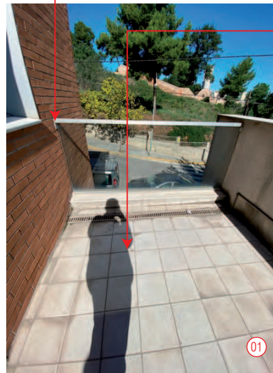
08.03. PAVIMENT EXTERIOR, DE RAJOLA DE GRES EXTRUÏT SENSE ESMALTAR ANTILLISCANT
