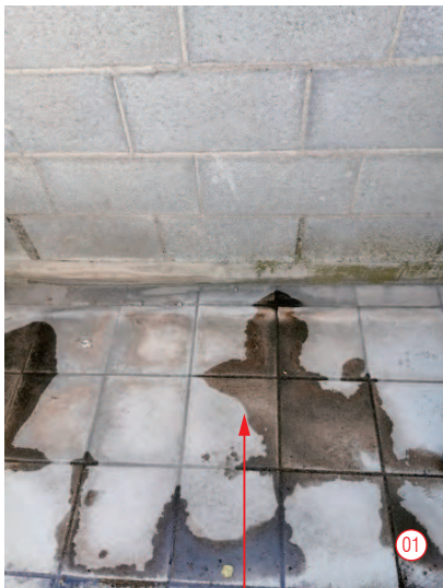
26.02. DESGUASSOS EN BAÑOS
