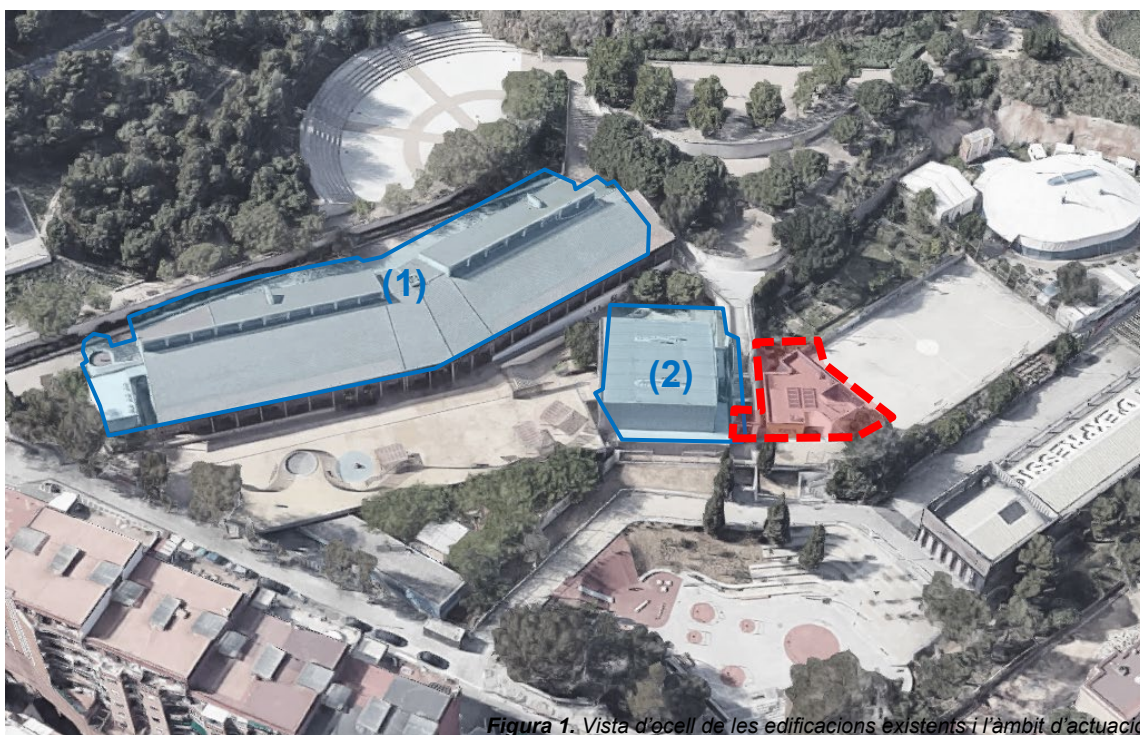
Figura 1. Vista d'ocell de les edificacions existents i l'àmbit d'actuació
