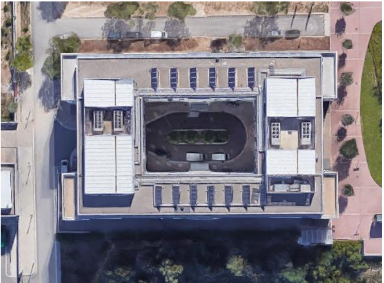
Imatge 1: Vista aèria dels edificis Llevant i Xaloc
