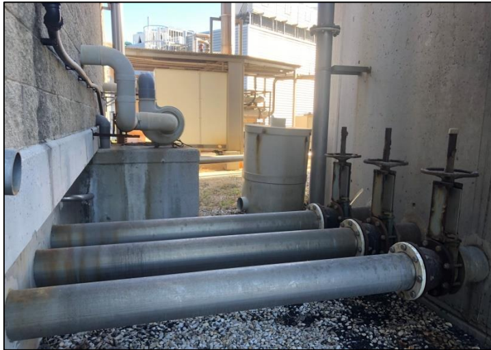
Imatges núm. 8 i 9 – Vàlvules i carrets antivibratoris existents a les canonades exteriors recirculació.
