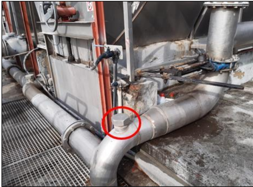
Imatge núm. 10 – Accés tipus amb tap roscat que s’haurà d’instal·lar a cadascuna de les canonades d’entrada de la recirculació.
