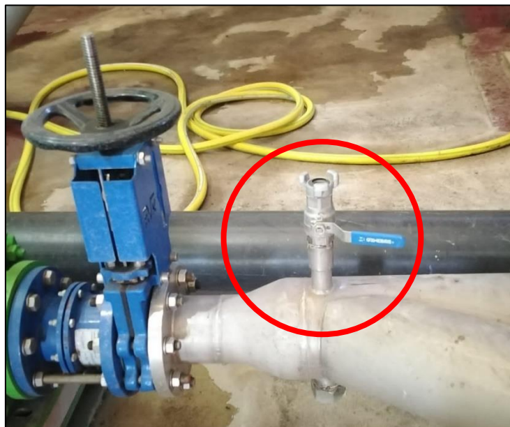
Imatge núm.11 – Picatge amb vàlvula tipus que s’haurà d’instal·lar a cadascuna de les canonades d’entrada de la recirculació.
