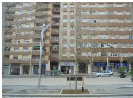
Plantació de l'arbrat amb instal·lació acabada de tub drenant.
