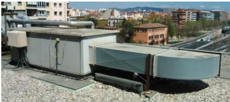
Fig. 3. UTA esquerra i UTA de la zona dreta, amb el muntant i el quadre elèctric adossat.
