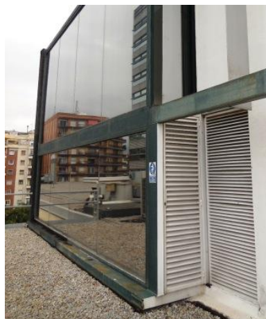
Fig. 7. Reixa de ventilació natural del badalot de l'escala
