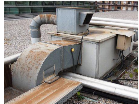
Fig. 3. UTA esquerra i UTA de la zona dreta, amb el muntant i el quadre elèctric adossat.
