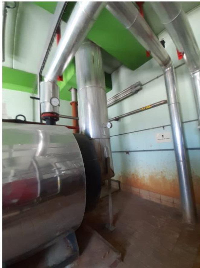
Instal·lació caldera a substituir (sortida fums)
