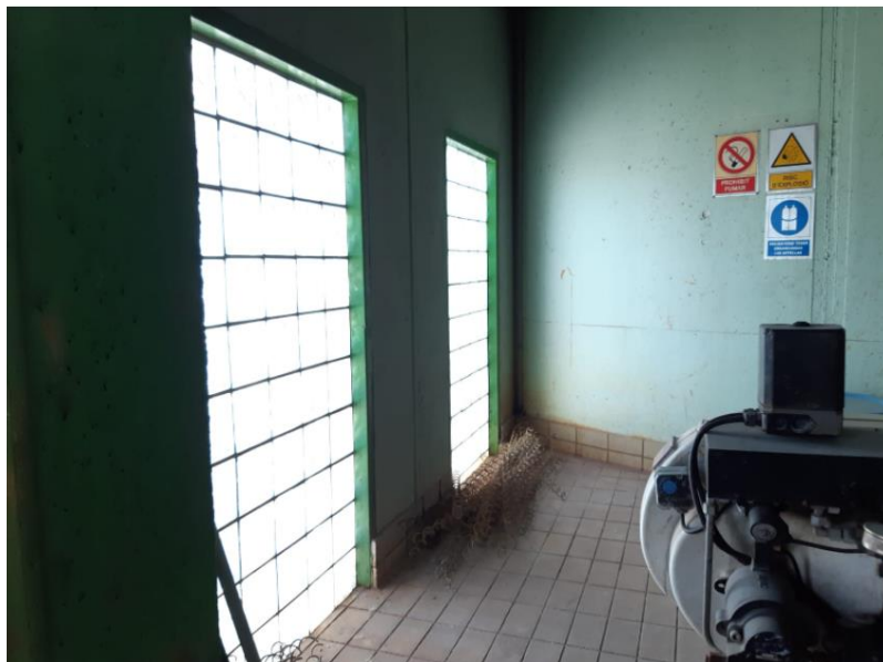
Accessos a la sala
