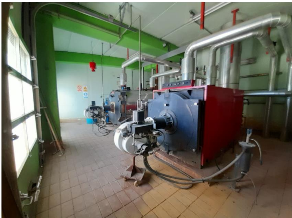
Caldera a reposar (esquerra) i caldera existent a mantenir (dreta)
