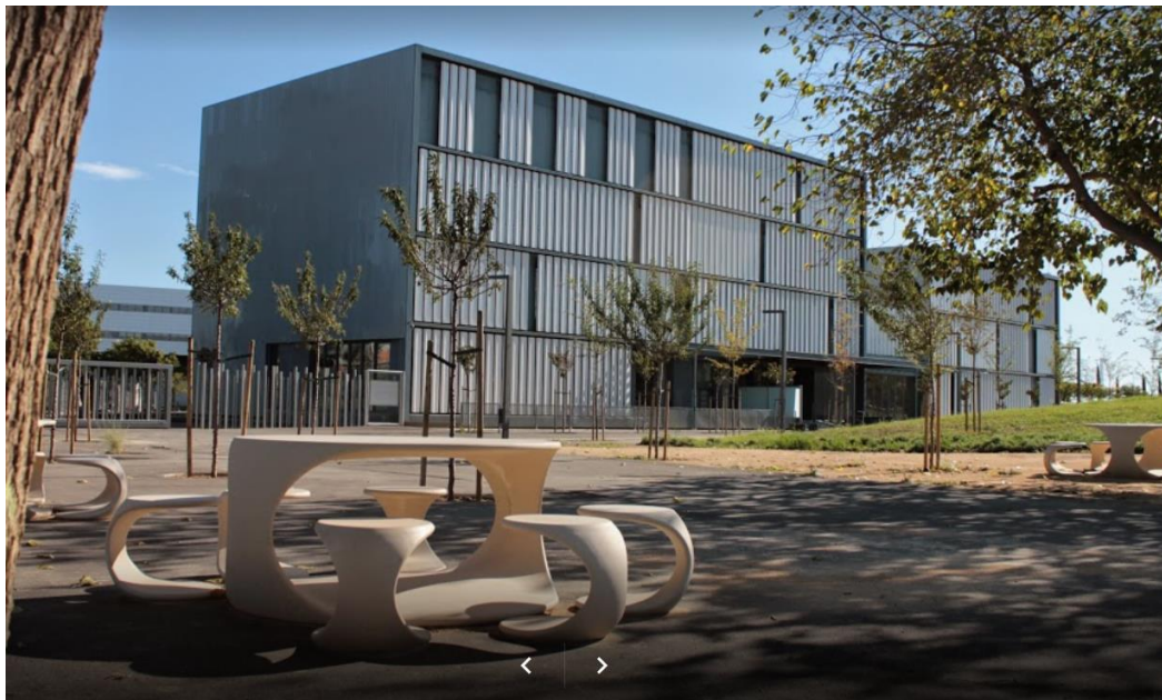
Imatge 1. Vista exterior façana oest edifici CTNS.
