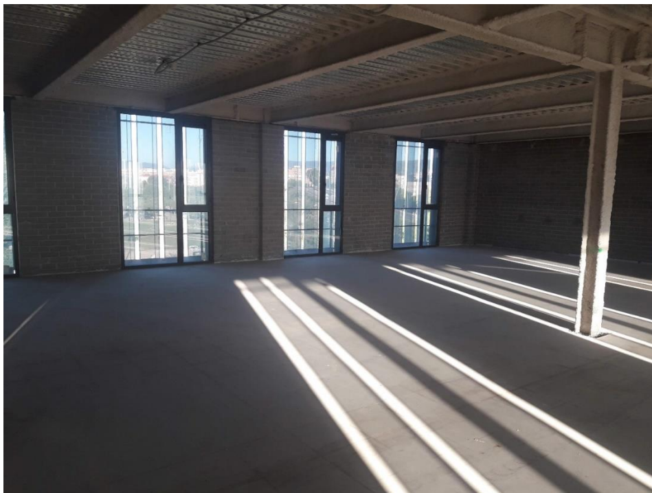
Imatge 2.. Vista interior cap a façana oest, amb primer pla de pilar metàl·lic i sostre de forjat col·laborant.
