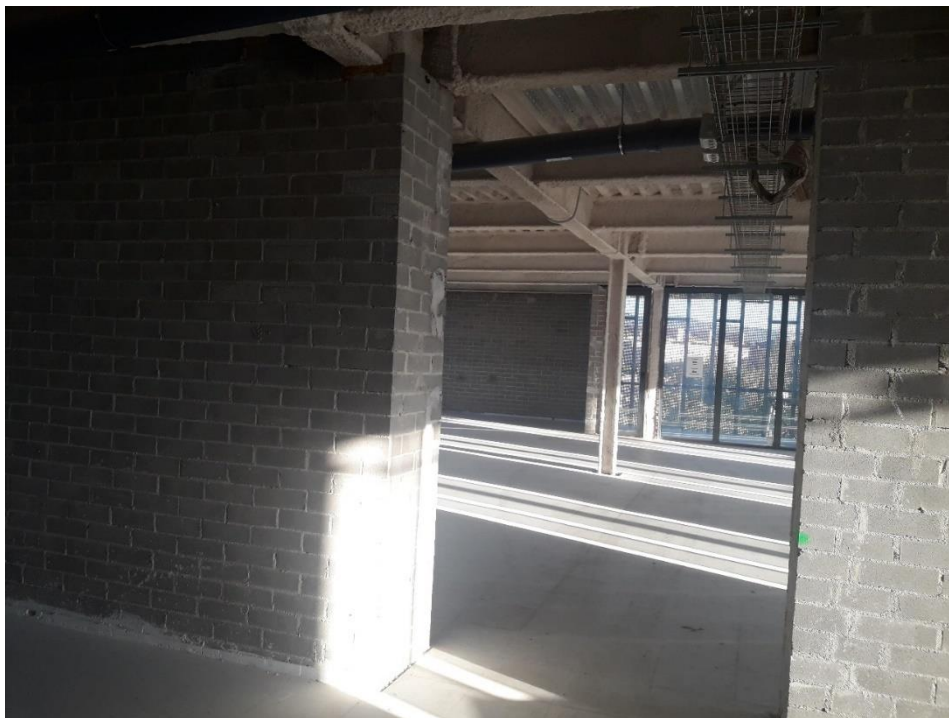
Imatge 4. Vista interior central. Divisòries de maó calat de formigó pels passos d'instal·lacions.
