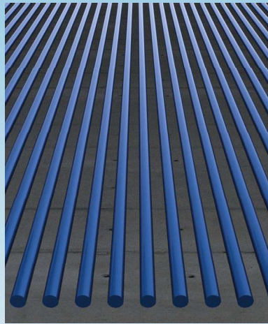
Detall de doble pell, panell de formigó + tubs circulars d'alumini de 110mm de diàmetre pintats amb pintura especial per a carrosseria de vehicles
