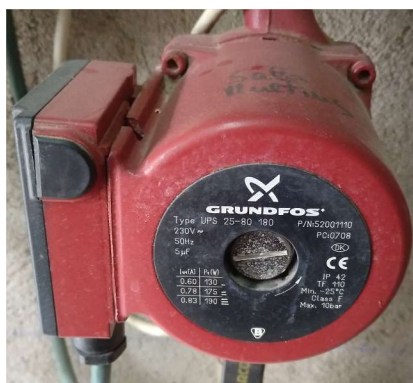
Imatges 2, 3 i 4.- Bombes circuladores per a calefacció de l'edifici de la llar d'infants
