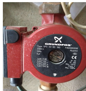
Imatges 2, 3 i 4.- Bombes circuladores per a calefacció de l'edifici de la llar d'infants
