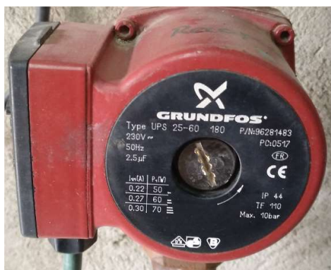
Imatges 2, 3 i 4.- Bombes circuladores per a calefacció de l'edifici de la llar d'infants
