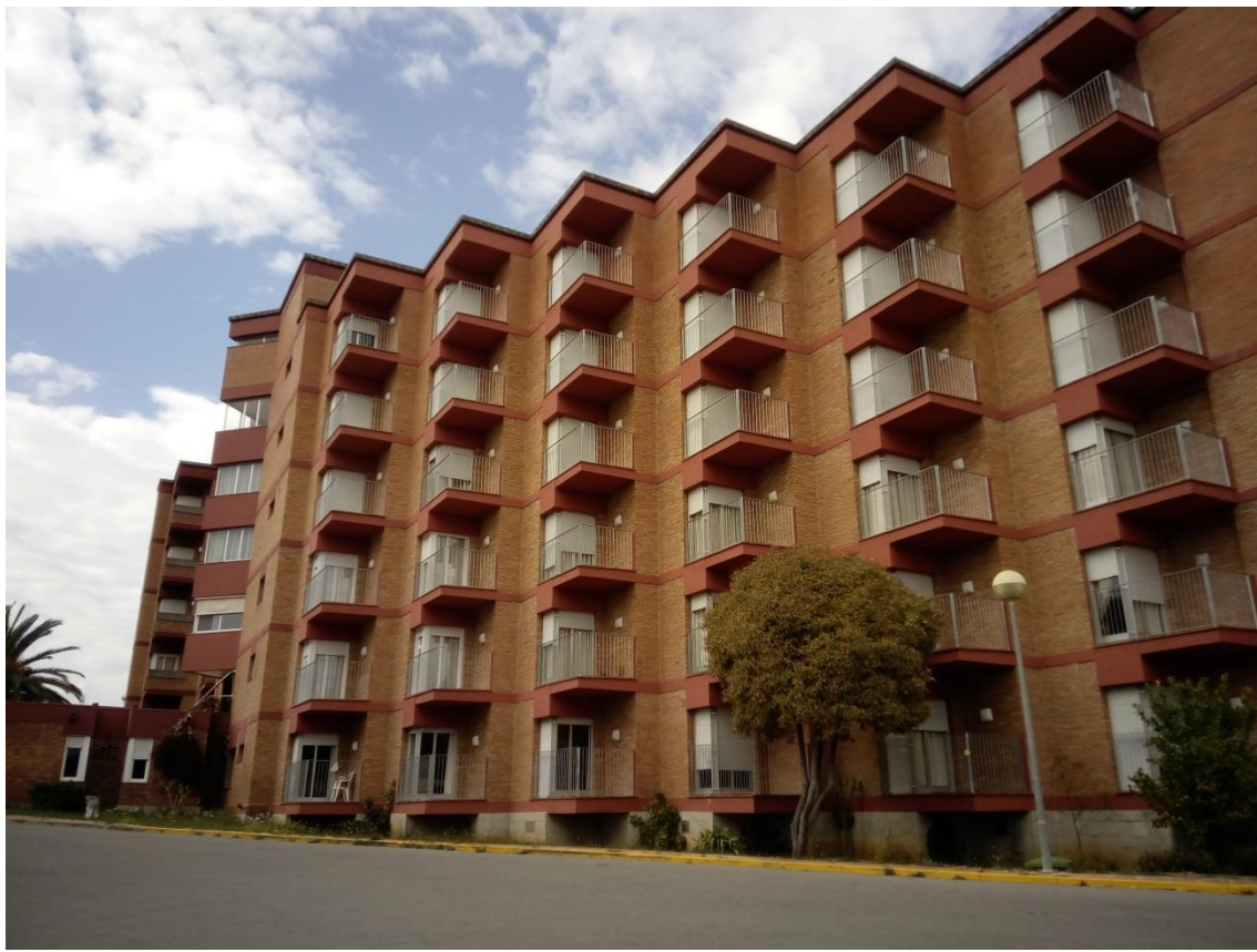
Imatge 1. Façana principal
