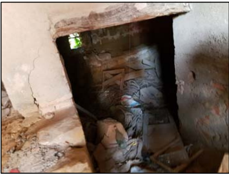
INTERIOR: PAS ENTRE NIVELL 0 I NIVELL -1
