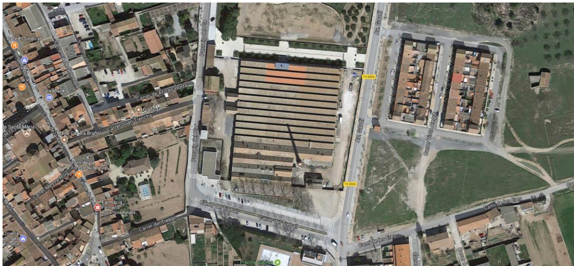
FIG. 2.- Relació de la fàbrica amb les vies d'accés: el passeig del Pla, el carrer del Treball i l'avinguda Gaudí
