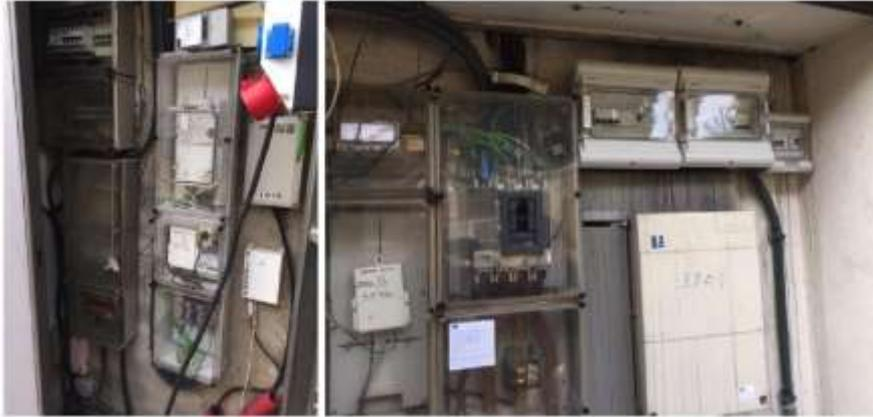
**Fig. 2.6. Contador bidireccional FV (izquierda) y los cuadros de alterna (derecha)**
