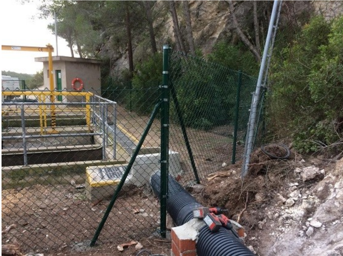
Vista del tub i la tanca perimetral reparats.
